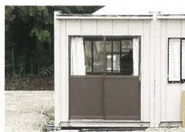
出荷調整室 (約60万円/25㎡※プレハブ小屋の場合)
