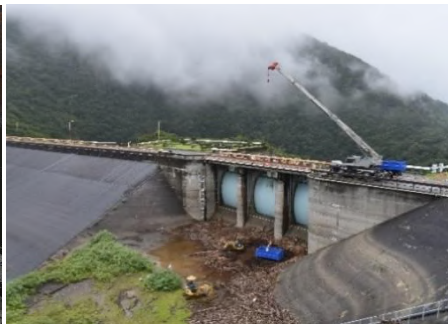
深山ダム：流木処理
