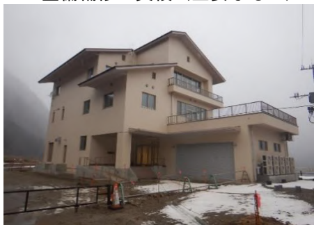
深山ダム：管理棟新築工事
