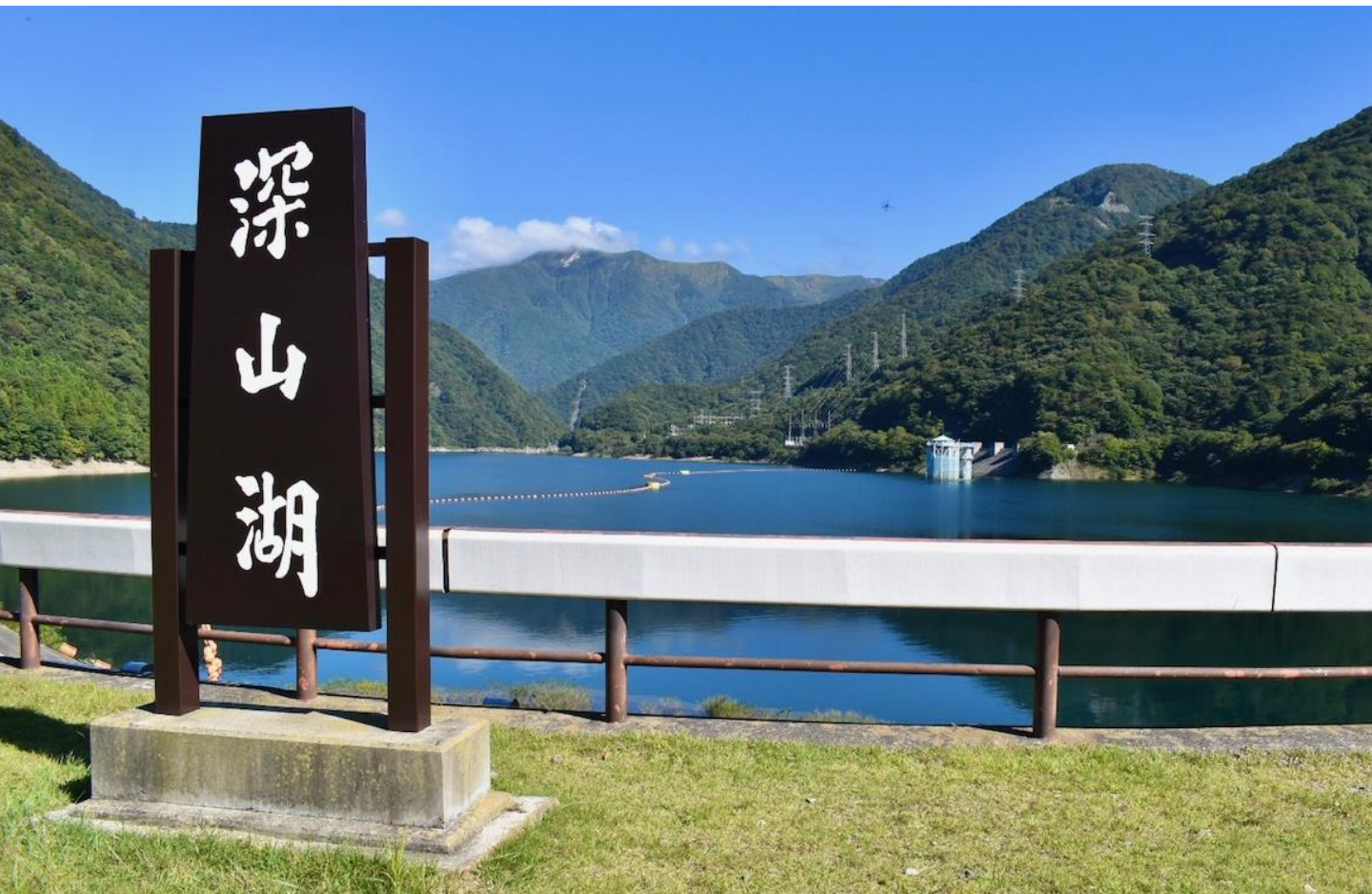
建設50周年を迎えた深山ダム
