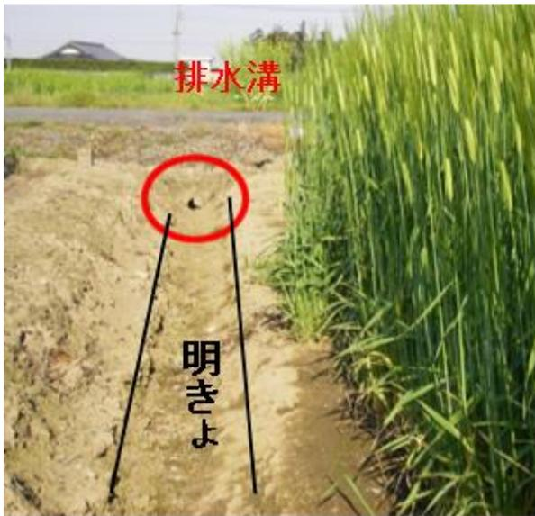
写真2 排水溝に接続されている明きよ
