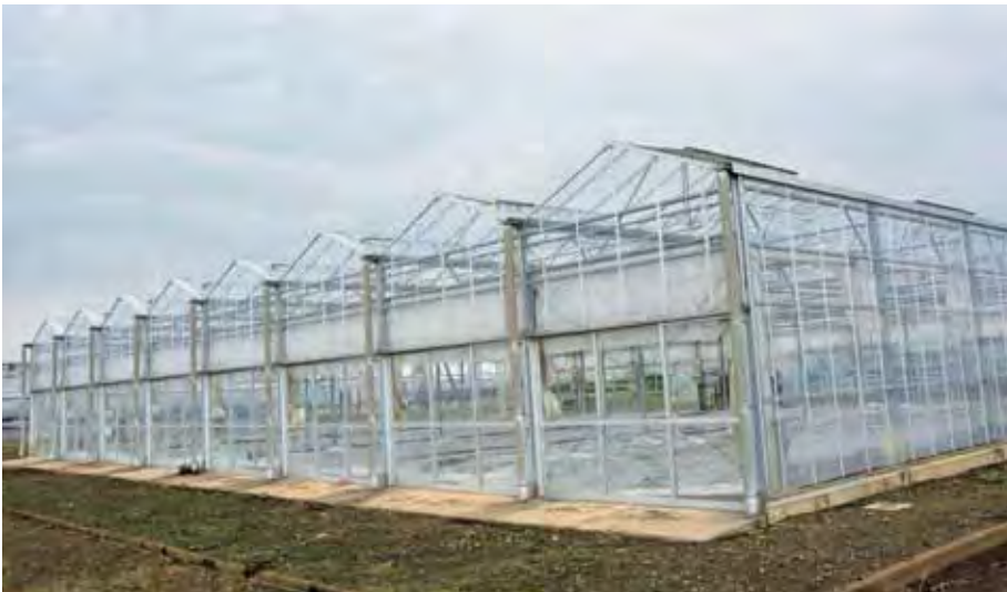
平成17年に新設された育種用の温室
