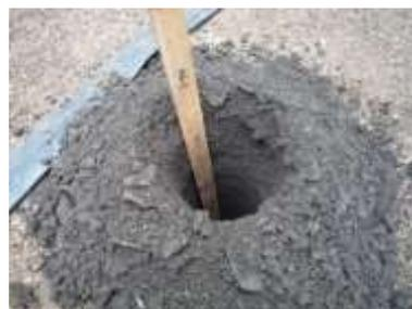
写真3 直径10cm、深さ55~60cmの穴を掘削
