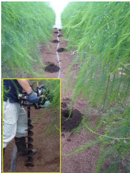
写真1 エンジンオーガーで通路中央に千鳥状に2m間隔で縦型暗渠設置作業の様子
