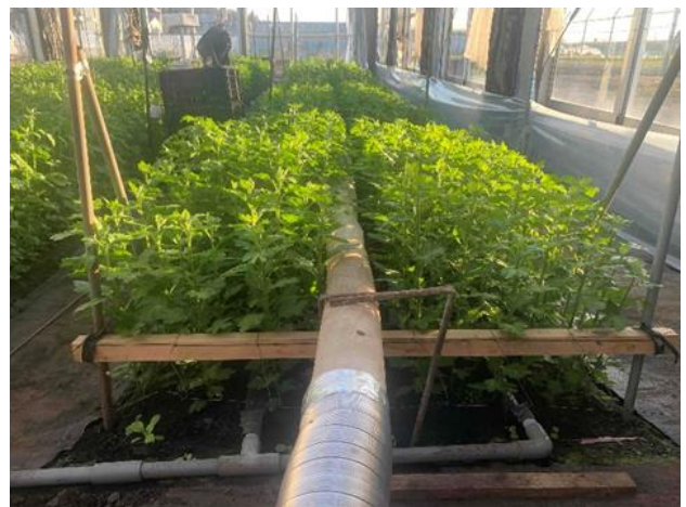
写真 フラワーネットの上に設置した温風ダクト
