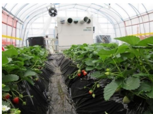
写真1 水熱源ヒートポンプ設置状況
