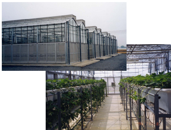
完成した原々苗総合生産施設
