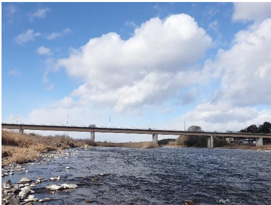
地点7 八溝大橋 下流
