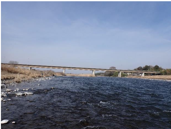
地点7 八溝大橋 下流
