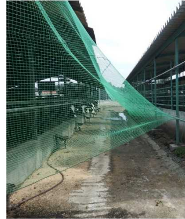
写真6 防鳥ネットの設置
