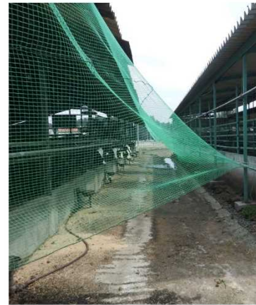
写真6 防鳥ネットの設置
