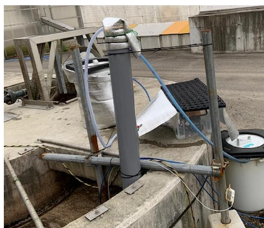
図4 曝気槽内に設置した硫黄脱窒装置
