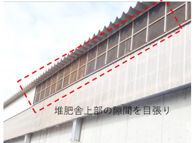
図 13 強制発酵施設の目張り等の対策を実施した部分
