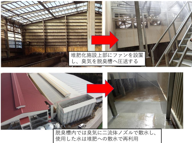
図 15 脱臭槽の原理
