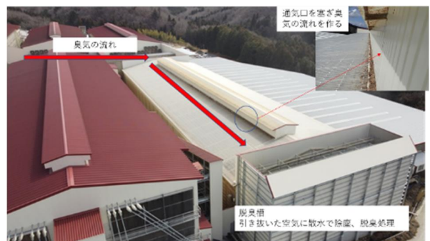
図 14 脱臭槽の設置図
