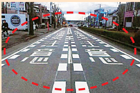
区画線の設置（県道宇都宮向田線／宇都宮市）
