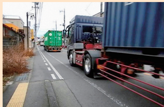
重要物流道路の整備 (国道400号／大田原市新富町)
