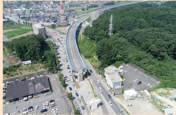
地域高規格道路の整備 (国道119号／宇都宮環状北道路)
