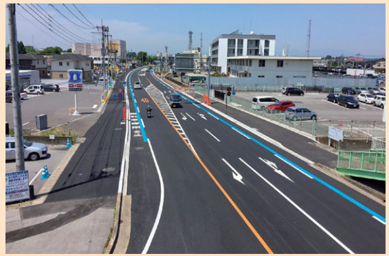
自転車通行帯の整備（県道西小埜真岡線／真岡市）
