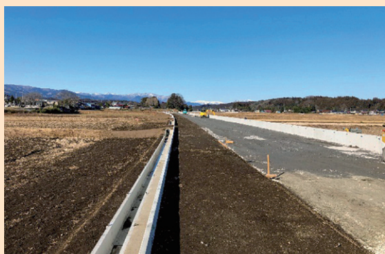
県道矢板那須線（矢板市泉）
