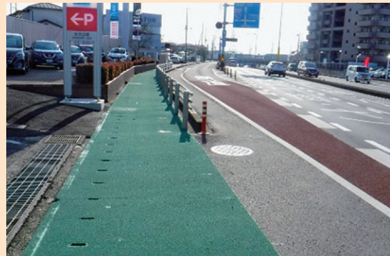
安全対策 (カラー舗装) (国道119号/宇都宮市)
