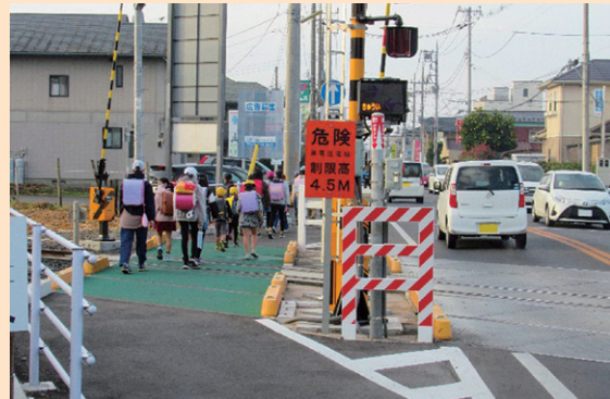
歩道整備 (県道粟宮喜沢線/小山市)
