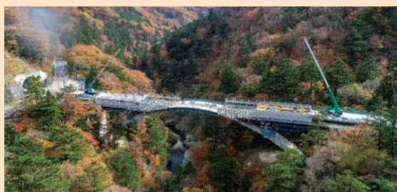
アクセス道路の整備 (国道400号/那須塩原市)
