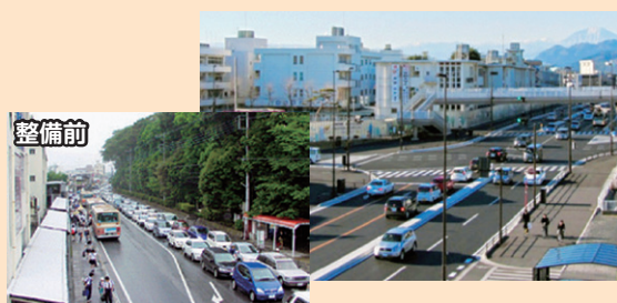
道路の拡幅整備 (県道宇都宮今市線/宇都宮市)
