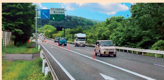
アクセス道路の整備 (国道120号/日光市)
