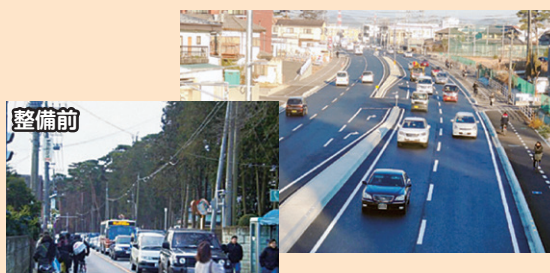
道路のバイパス整備 (県道宇都宮真岡線/宇都宮市)
