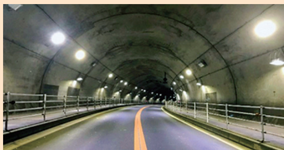
トンネル照明LED化 (県道宇都宮那須烏山線 / 神長トンネル)
