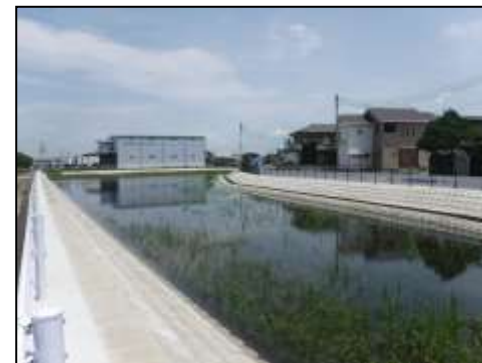
雨水調整池 （武名瀬川第三調整池 上三川町）
