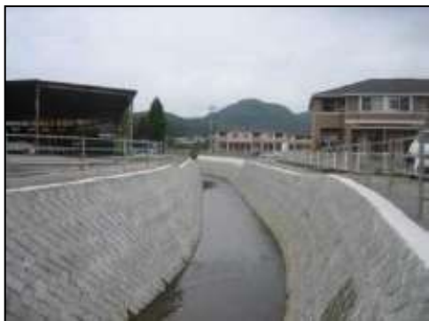
河川整備（小藪川 鹿沼市）
