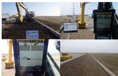
【ICT建機による盛土状況】
