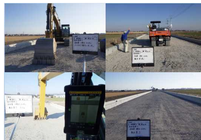
【ICT建機による置換工 (有効層)】
