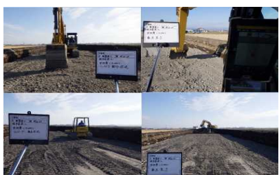
【ICT建機による置換工 (無効層)】
