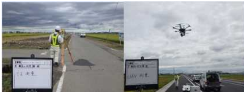
【UAVによる起工測量】
