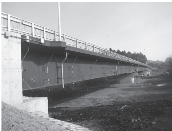
図2-6-39 佐貫観音橋 (下流から)
