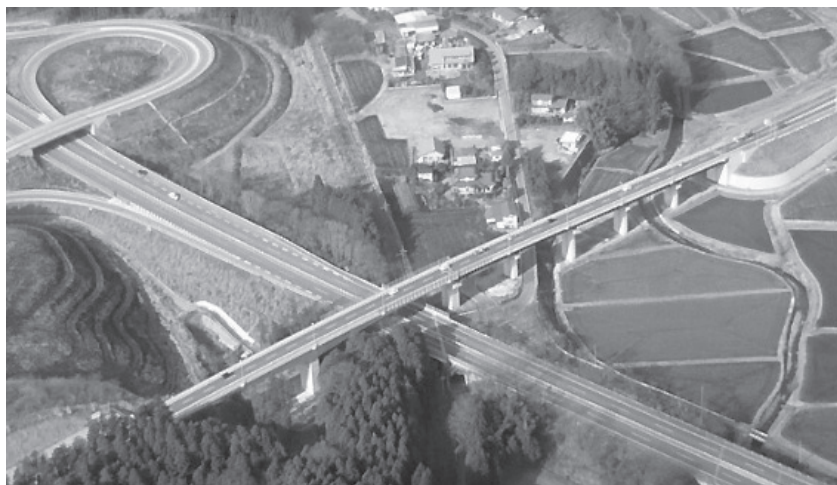
図 2-6-22 土沢大橋 (南東から) (中央に JR 日光線、 左に日光道土沢 IC)
