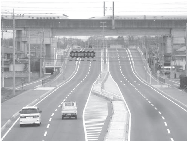
図 2-6-47 西那須野跨線橋
