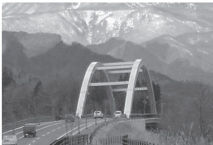
図2-6-29 日光七里大橋（南東から）
