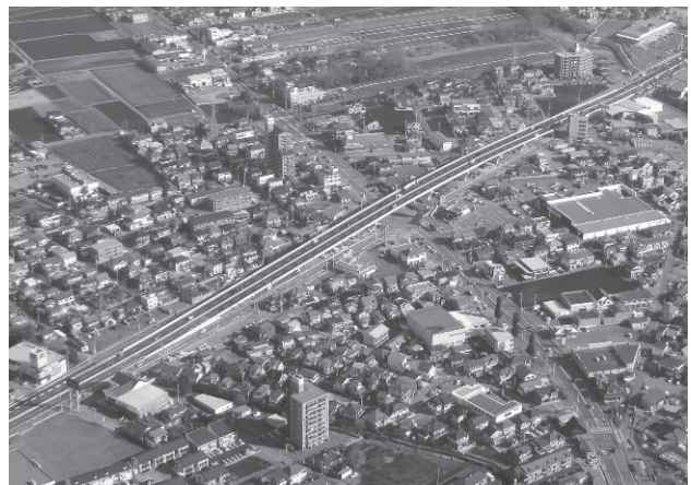
図 2-6-6 宮環・下川俣陸橋 (南西から)
