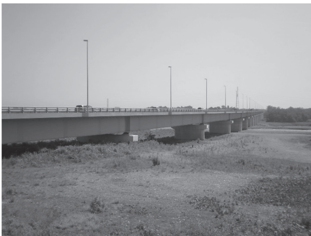
図 2-6-13 板戸大橋 (下流から)
