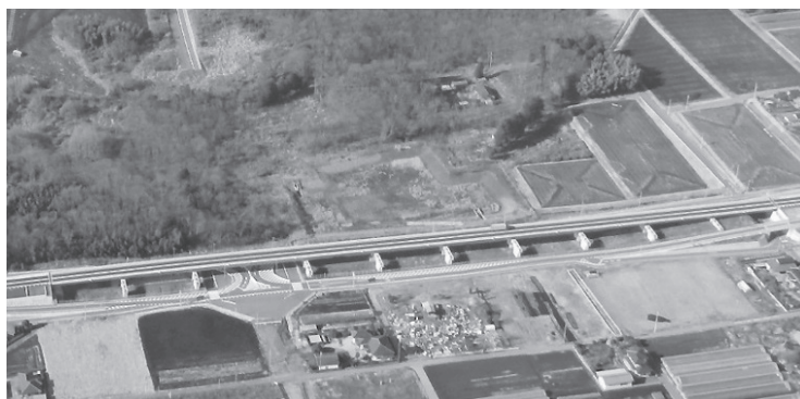
図2-6-9 清南大地高架橋 (東から)
