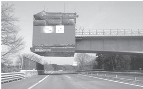
図 2-6-28 土沢大橋 施工状況 (西から) (日光道は高さ制限をかけた)
