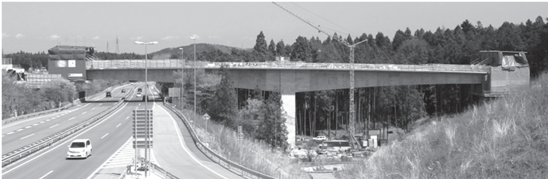
図 2-6-27 土沢大橋 T ラーメン張出架設工法 (移動作業車内で左右均等に桁を打設、緊張) (西から)
