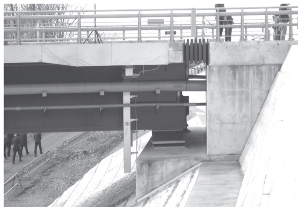
図2-6-36 大光寺橋 右岸側継手部(上流から)
