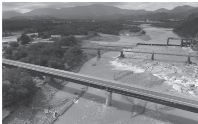
図2-6-43 平成28年9月 被災時(下流から)
