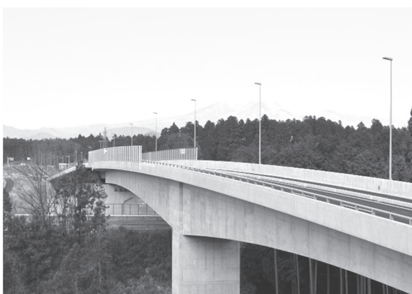
図 2-6-23 土沢大橋 PC 橋部 (南西から)
