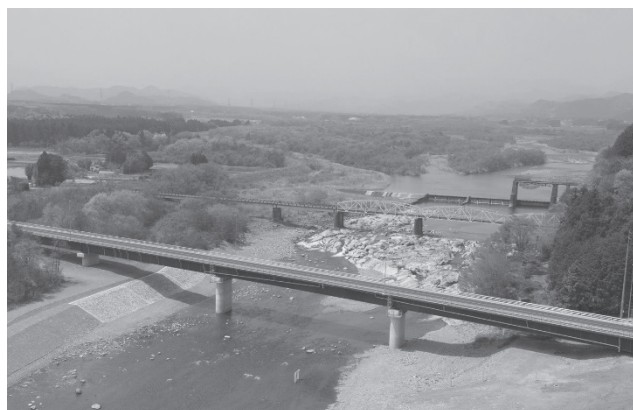
図2-6-42 平成27年3月 完成時 (手前から新橋、旧橋(撤去予定)、河床露岩、佐貫頭首工)
