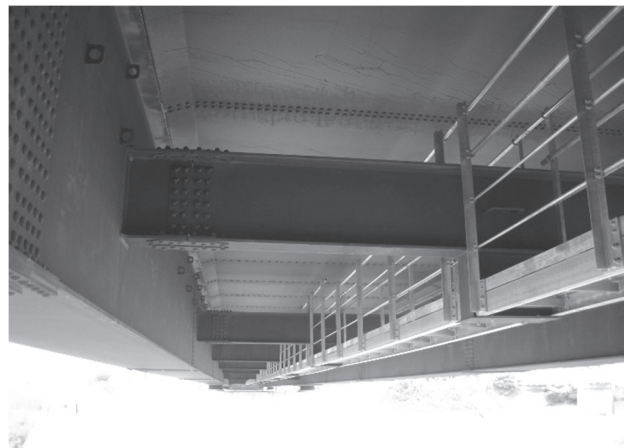
図2-6-1 大光寺橋 (下面から)
