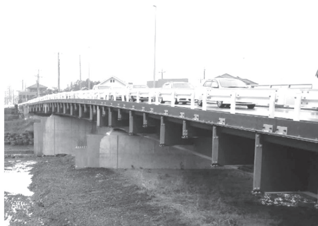
図 2-6-58 白旗橋 上流側 (1 期) 完了写真
