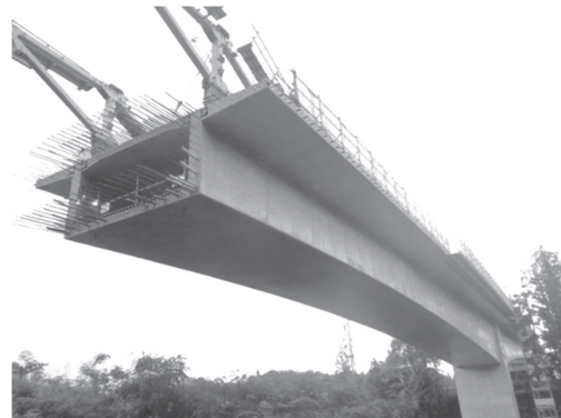
図 2-6-28 土沢大橋 施工状況 (南から) (移動作業車の覆いが無い状態)
