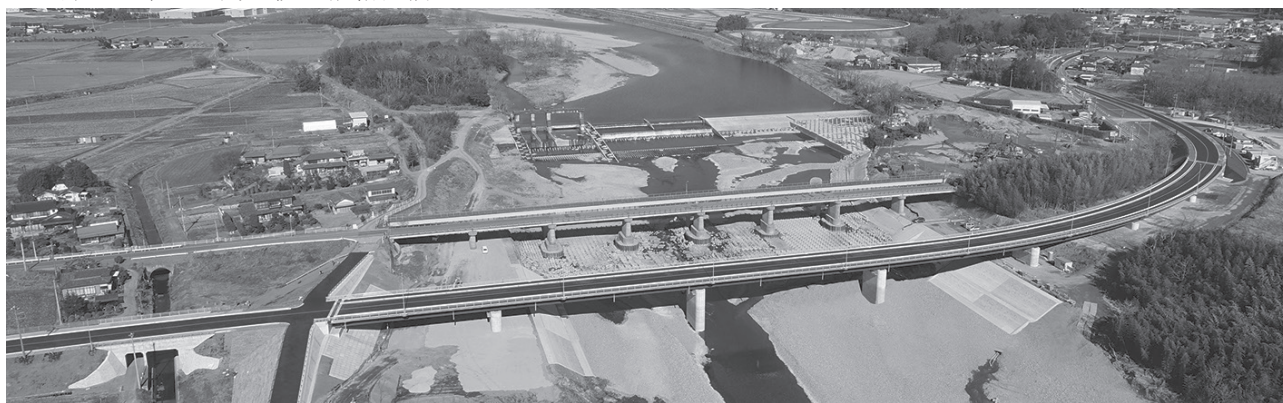
図2-6-34 大光寺橋 (手前から新橋、旧橋(撤去予定)、美田東部頭首工)(下流から)
