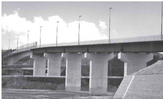
図 2-6-24 土沢大橋 鋼橋部 (北東から)
