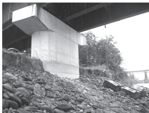
図2-6-45 同左出水後P2橋脚前面洗掘状況
