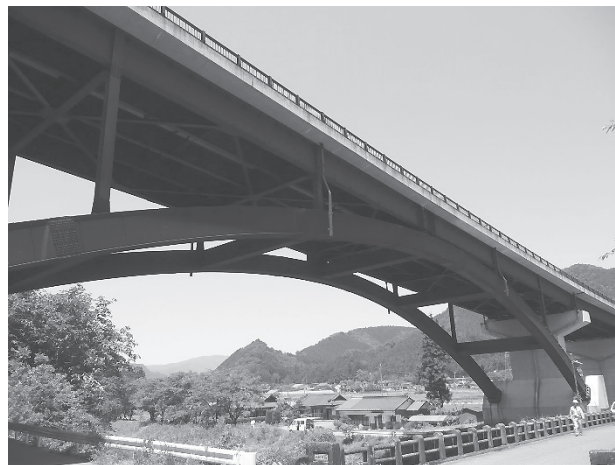
図2-6-16 新大越路橋 (右下は旧橋)
