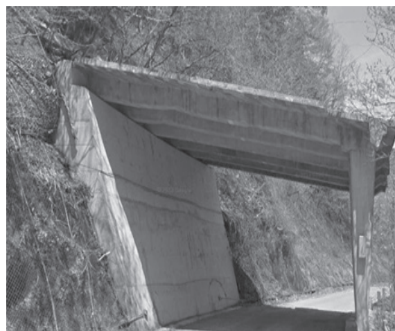
図3-3-9 (一)黒部西川線 日光市 スノーシェッド
