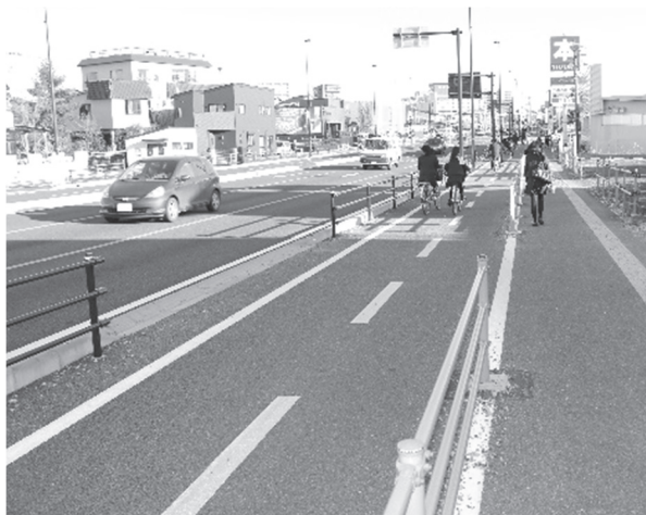
図 3-4-7 宇都宮市一の沢工区 (H26.3 自転車道として歩道を分離)
