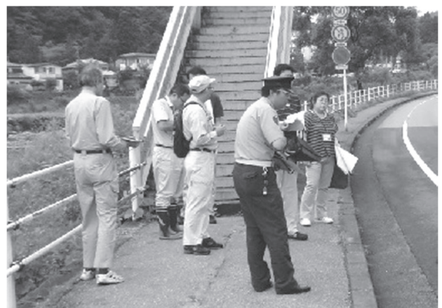
図3-4-2 合同点検実施状況
