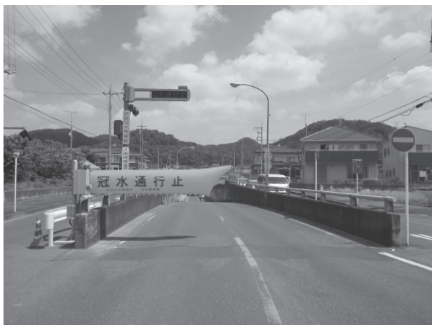
図3-3-6 (主) 足利環状線 足利市 山川アンダー 冠水通報装置 と連動したエア一式遮断機
