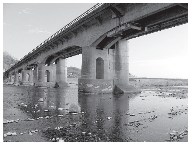
図3-2-5 (主) 矢板那珂川線 那珂川町 新那珂橋
