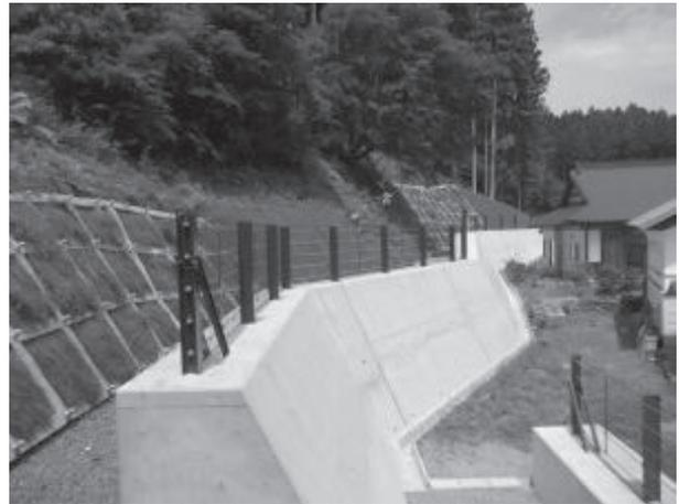
図 6-4-5 矢板市倉掛 待受式擁壁工
