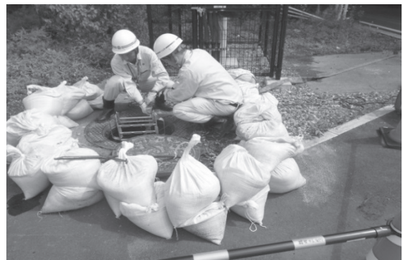
図10-4-10 訓練の状況（管渠）
