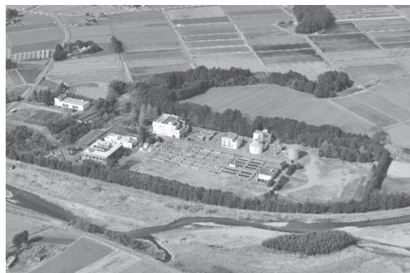
図 10 - 3 - 14 北那須浄化センター全景
