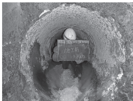
図10-3-19 劣化した管渠
