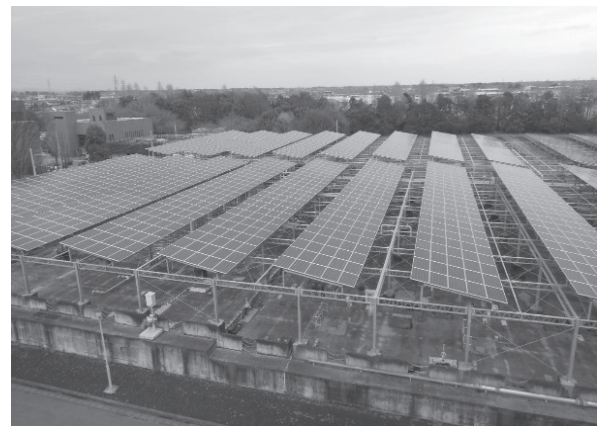
図 10 - 3 - 28 巴波川流浄化センター
