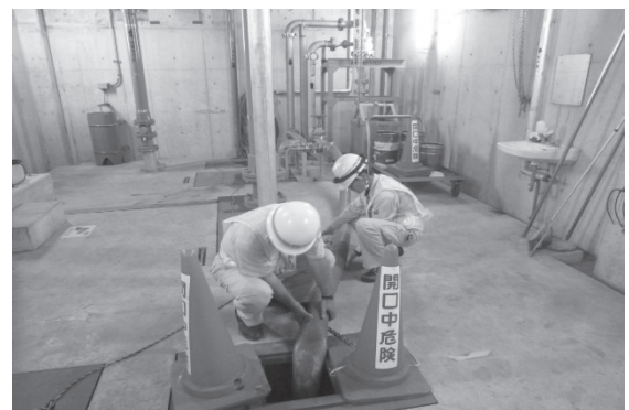
図10-4-11 訓練の状況（中継ポンプ場）
