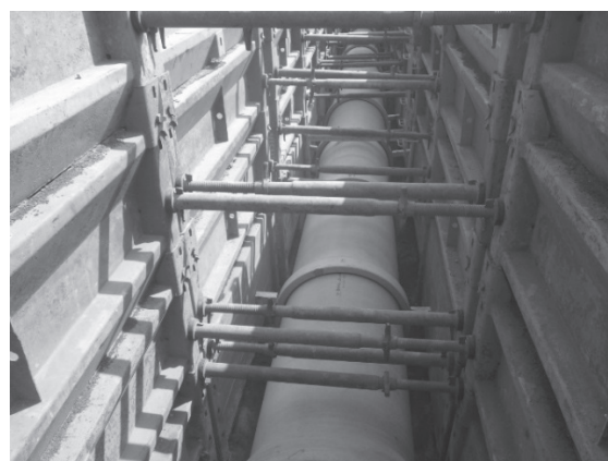
図 10 - 3 - 6 真岡市雨水管渠
