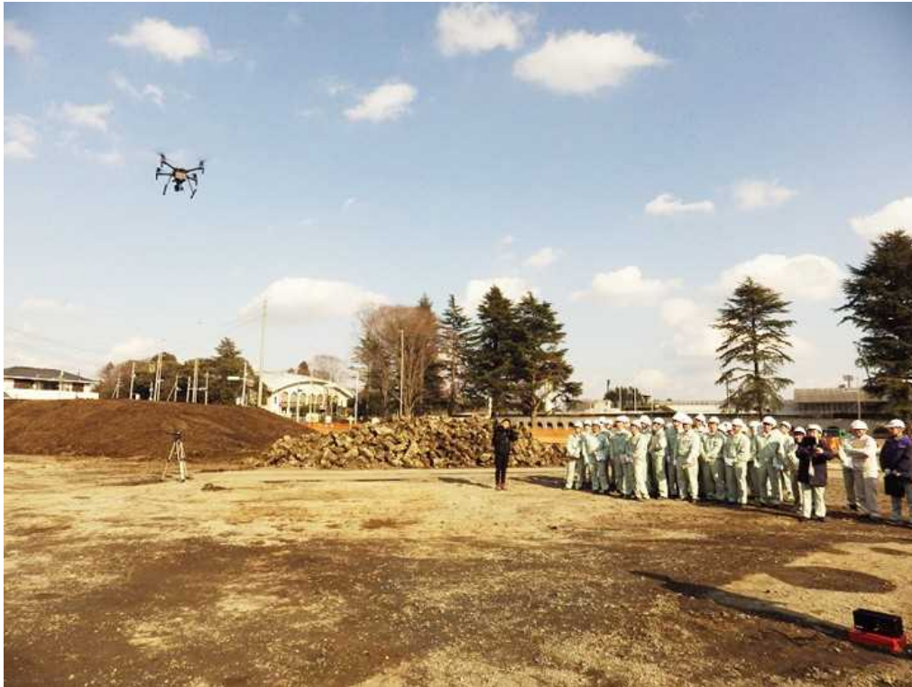
ドローンによる測量状況の確認
