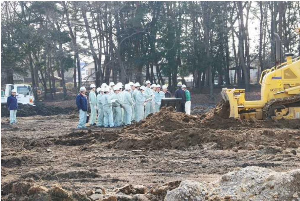
ICT 技術を活用した西駐車場造成工事の施工
