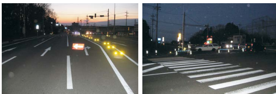
(国) 408号鬼怒テクノ通り 全面通行止め状況 (真岡上三川線交差点)
