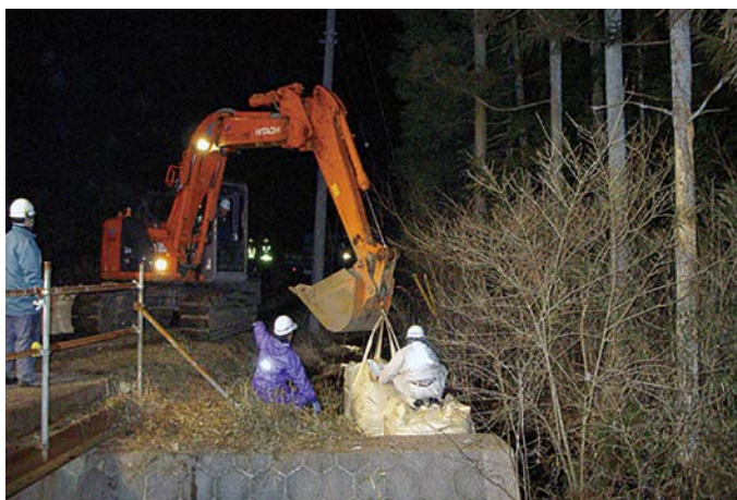
〈板敷川仮排水路 応急復旧工事状況〉
