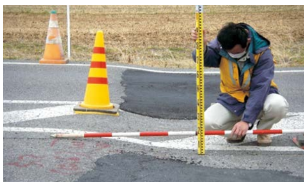
(一) 西田井二宮線（真岡市鹿 カントリーエレベーター付近）
