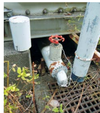
受水槽の蛇口
