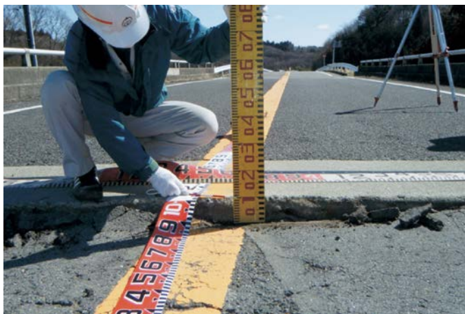
〈(主) 那須高原線 丸山陸橋 橋台部段差状況〉
