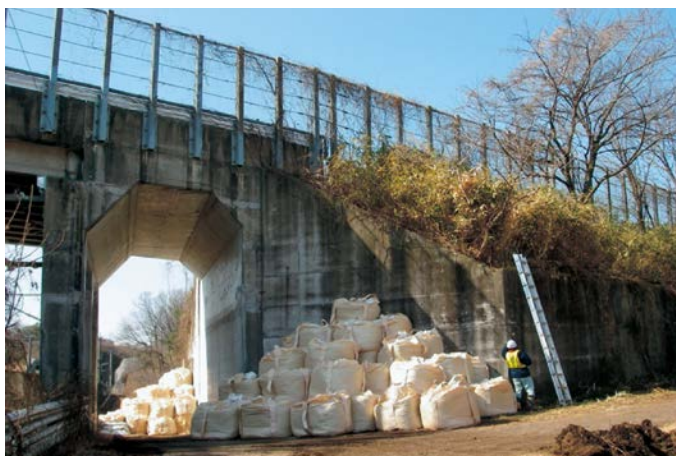
〈(一) 豊原高久線 廻り谷橋 (JR東北線跨線橋) 橋台擁壁傾斜により応急復旧工事状況〉
