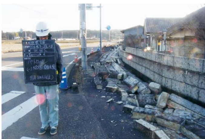
〈(一) 蛭畑須佐木線 石塀倒壊状況 (一般国道400号交差部)〉
