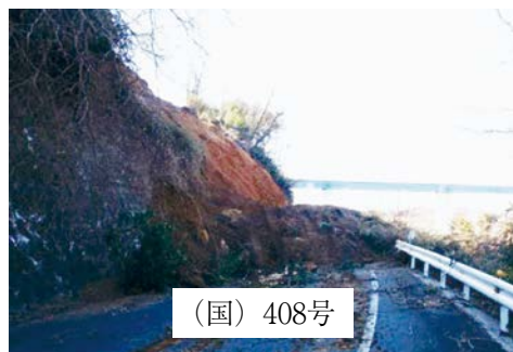
被災状況（南側起点）
