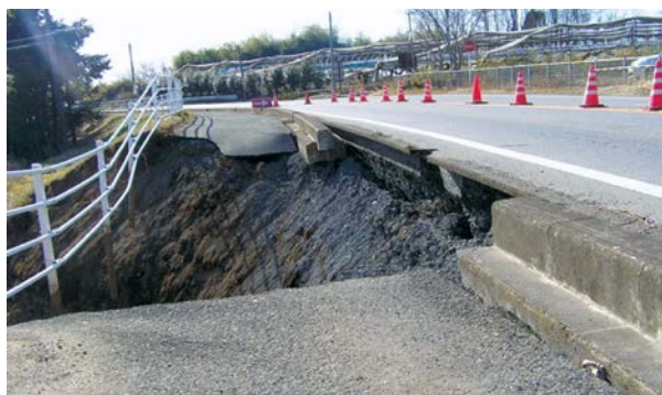
(主) 宇都宮向田線 (芳賀町給部) 見下げ法面崩壊
