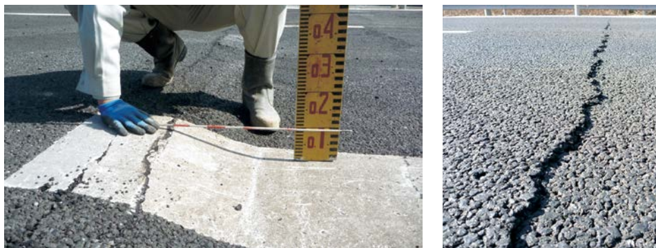
(国) 408号鬼怒テクノ通り (もめん大橋付近) 路面段差、亀裂
