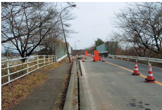
〈(一) 豊原高久線 廻り谷橋 路面段差状況〉
