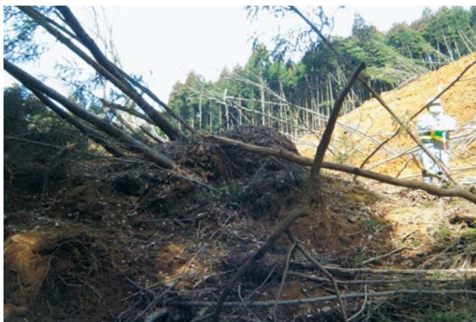
〈板敷川河道閉塞状況〉
