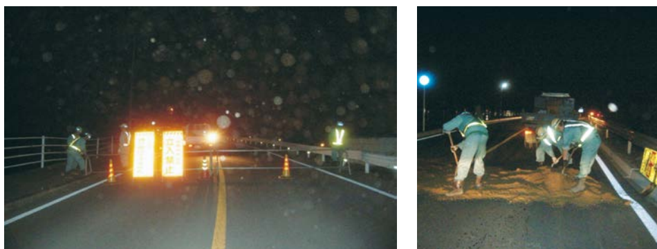
芳賀市貝バイパス (市の堀BOX前後) 全面通行止め及び復旧状況
