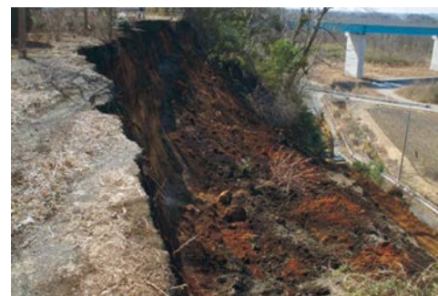
被災状況（上部から）
