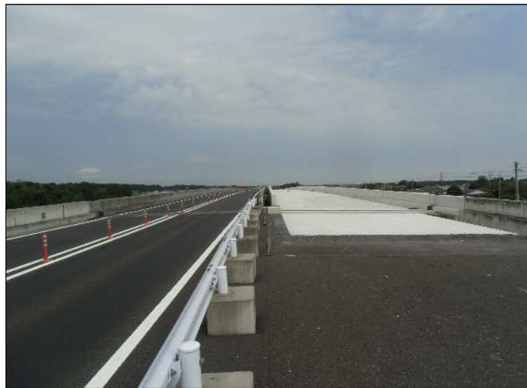
写真2: 暫定供用区間【清南大地高架橋】
