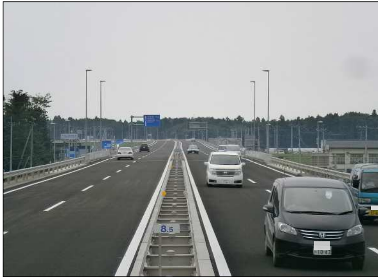
写真1: 完成供用区間【国道121号交差点】
