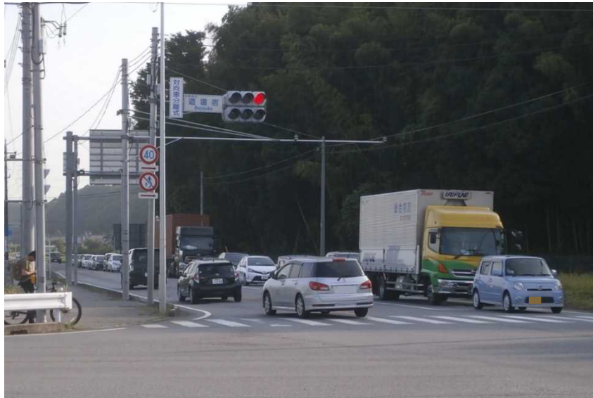
写真 2 : 現道の状況 (道場宿交差点北側)
