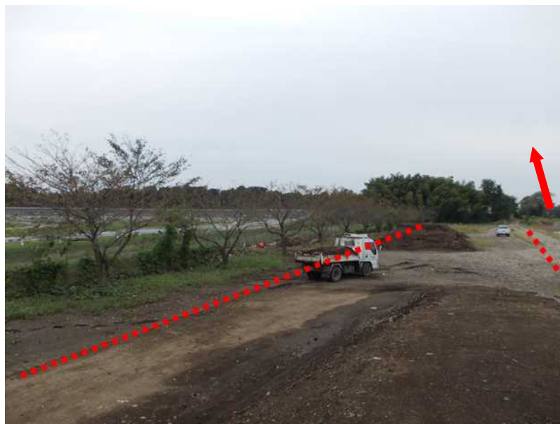
①堤防整備前 黒川合流点下流
