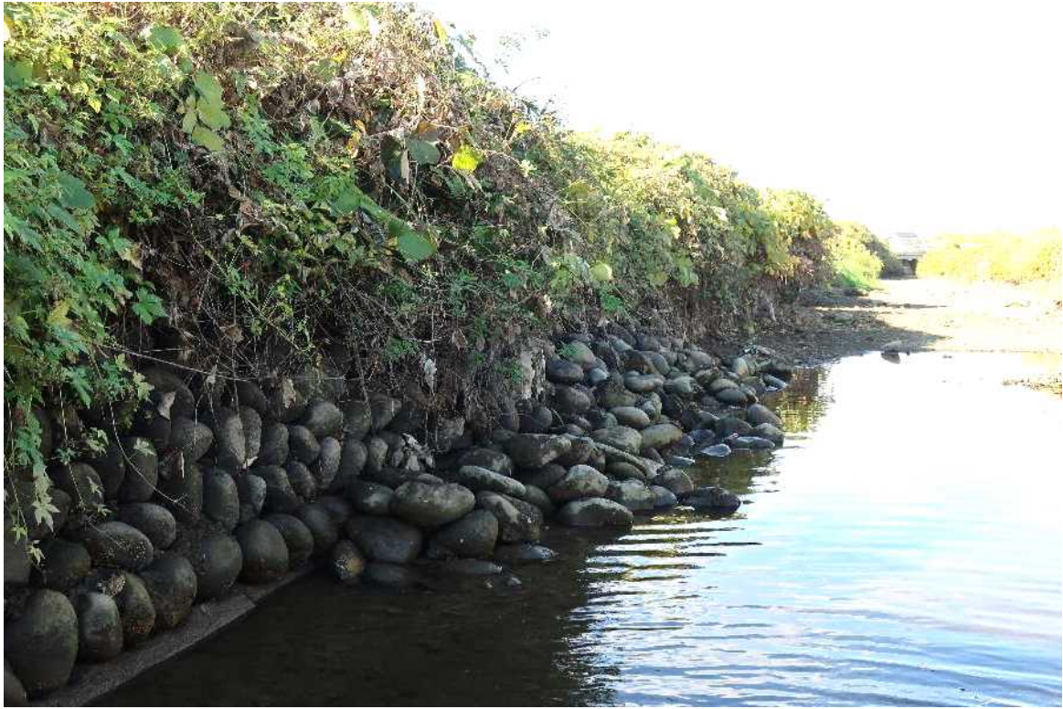
石積み護岸の崩落
