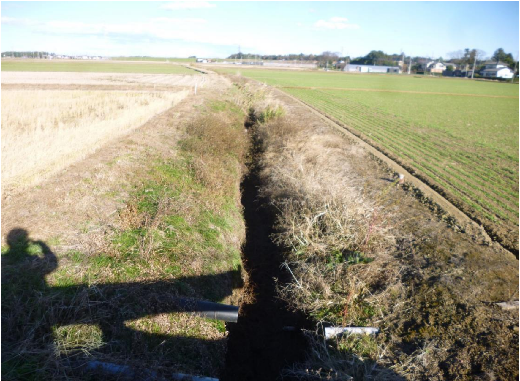
管理用道路がない現況排水路
