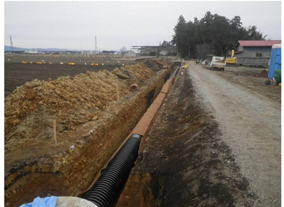
排水暗渠の施工の様子
