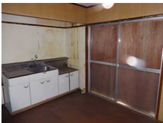
【建替前】給湯設備・換気扇なし
