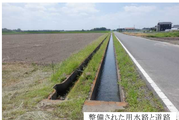
整備された用水路と道路
