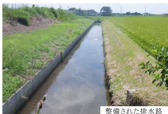
整備された排水路
