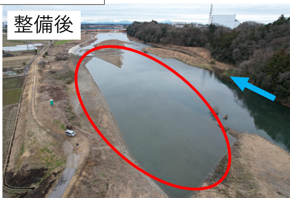
北半田地内（河道内土砂掘削）
