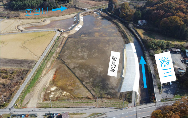
豆田川合流点上流（岩原調節池）
