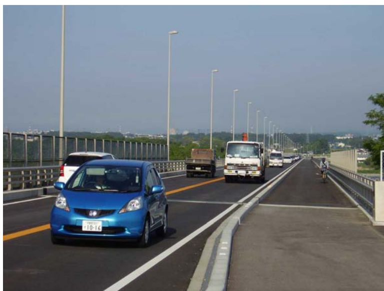
写真 3 : 供用区間板戸大橋
