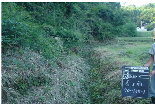
農業用排水施設（整備前）
