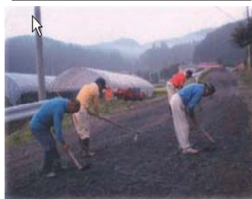
農地・水環境保全組織による道路補修
