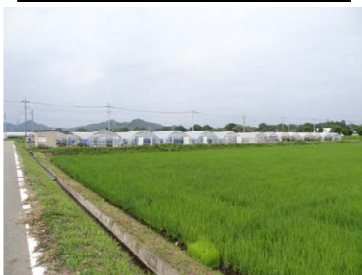
整備された用水路といちごのハウス
