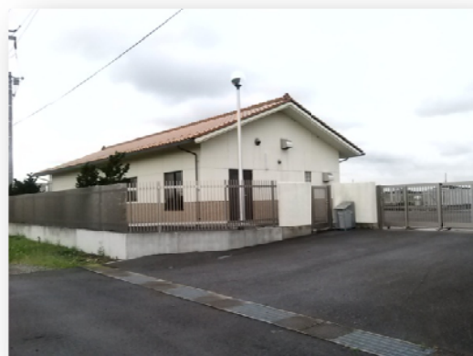
【上三川東部地区 処理施設全景】
