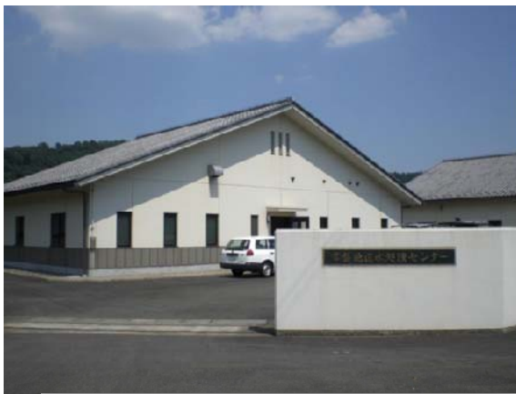
【常盤地区 処理施設全景】
