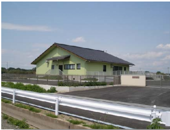
【延島地区 処理施設全景】
