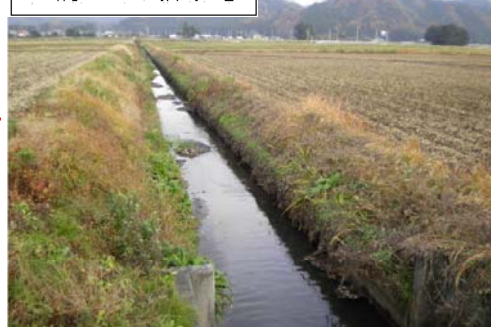
整備された排水路
