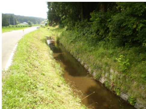
魚巣ブロックを設置した水路（山田地区）
