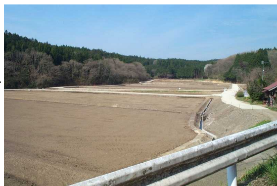
ほ場整備実施後（立足地区）
