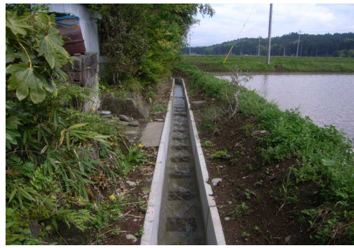
農業用排水路整備後（第2農場地区）
