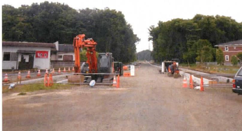
写真 3 : 隣接工区の施工状況 (市粟宮工区)
