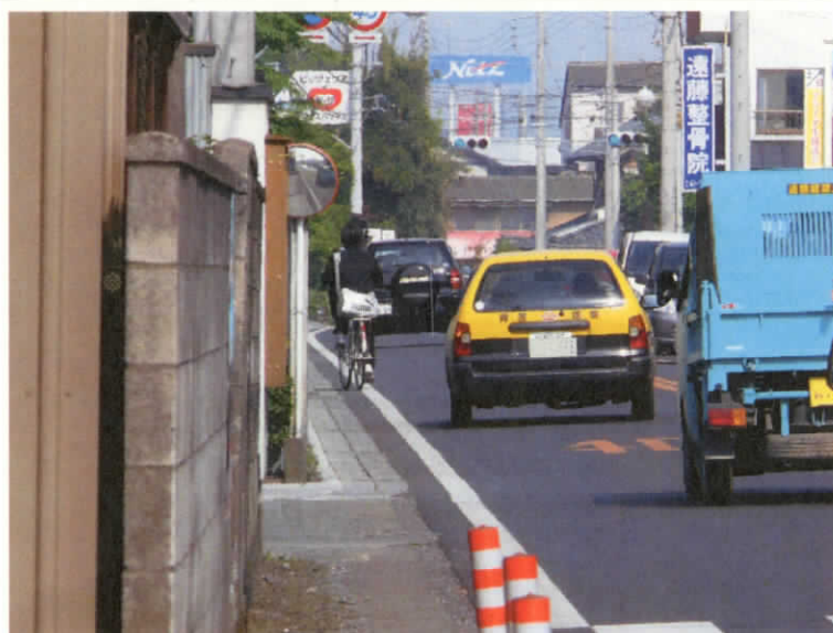
写真2：現道の道路状況（八柵町地内）
