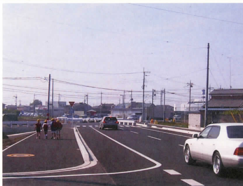
写真3：バイパス箇所供用状況（八柵町地内）
