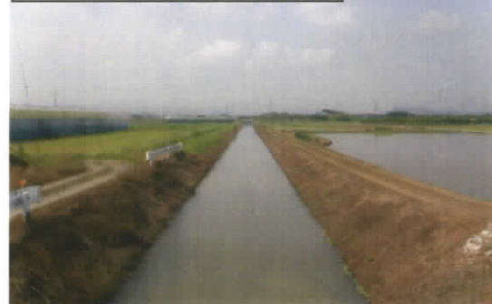
現在の幹線排水路 (H28.7)
