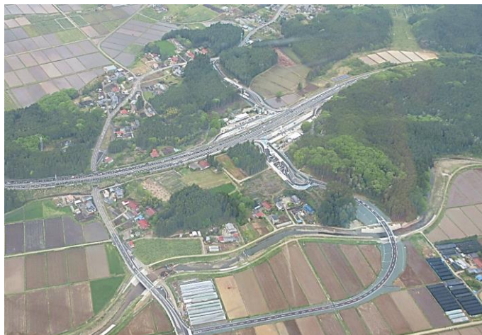
スマートICの整備 (東北自動車道 矢板北スマートIC)
