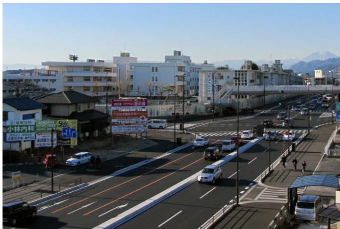
拠点間を結ぶ都市計画道路の整備 (都市計画道路大通り 宇都宮市)
