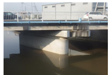
耐震補強 桐生岩舟線 弁天橋
