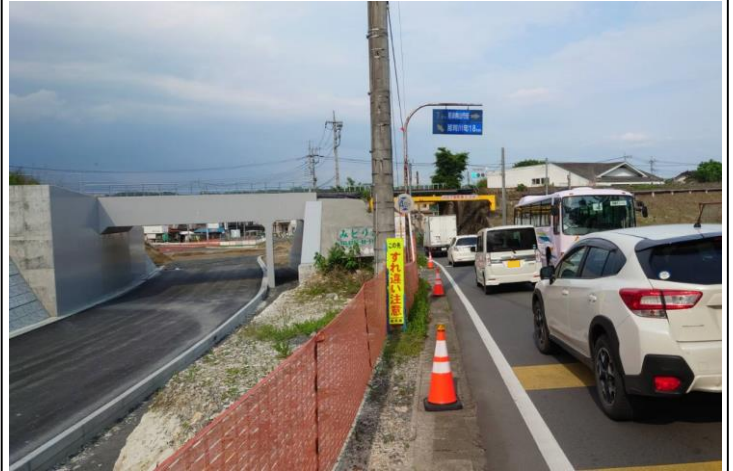
狭隘な鉄道立体交差の拡幅 (県道宇都宮那須烏山線 那須烏山市)
