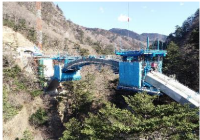
国道400号 下塩原バイパス(那須塩原市)
