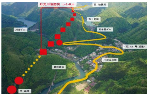
栃木西部・会津南道路 (国道121号 川治BP)
