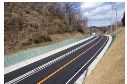
緊急輸送道路 国道293号 上川井工区 道路拡幅(那須烏山市)
