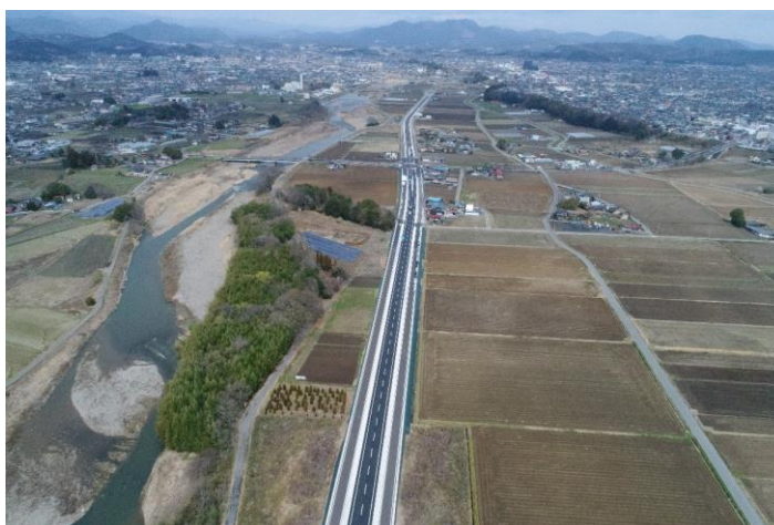
緊急輸送道路の整備 (国道293号 楡木バイパス 鹿沼市)
