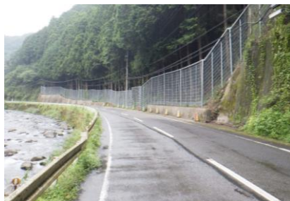
緊急輸送道路 (主)鹿沼足尾線 上粕尾工区 道路防災対策(鹿沼市)
