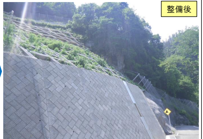
道路法面の防災対策 (県道仙波鍋山線 佐野市)
