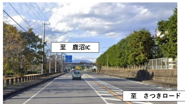
鹿沼工業団地内の状況
