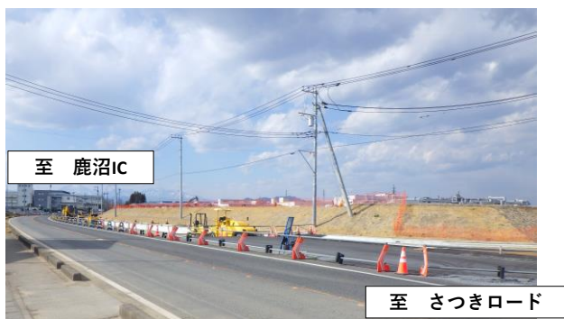
鹿沼インター産業団地内の状況
