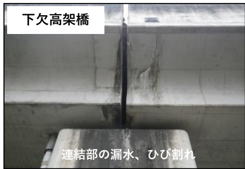
橋梁の現在の損傷状況
