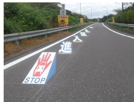
逆走防止対策の例②(路面標示)
