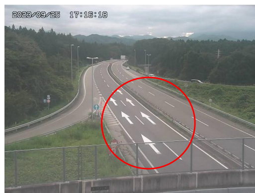
逆走防止対策の例①(路面標示)
