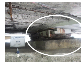
橋梁老朽化対策例②（日光IC橋）
